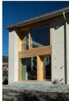
Bei der Küche wurde der ehemalige Holzverkleidung durch eine großformatige Verglasung ersetzt (Bild zu Fassadenschnitt)
