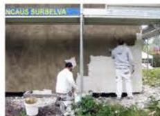
Auftragen des Putzes mit der kleinen Kelle auf die groß gearbeitete Metallbohrung. Der eher sanftige Verguss wird in kleinen Flächen aufgebracht.
