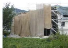
Schutz der verputzten Fassade vor zu schnellem Austrocknen mit Jalousievorhang. Die Arbeiten erfolgen Mitte September bei milder Witterung.
