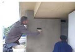
Oberfläche vertreiben mit dem Pinsel um die offene Poren zu schließen, im Anschluss an die Abfließen mit der Kelle. Der Putz erhält dadurch auch eine feinkörnige, kompaktere Wirkung.
